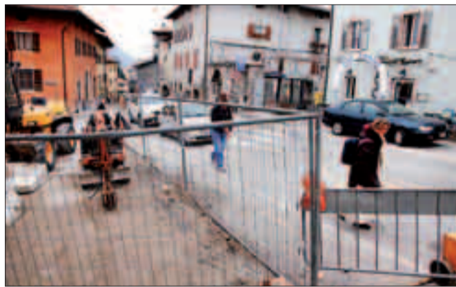
I lavori di via alla Veduta non fanno dormire alcuni abitanti
